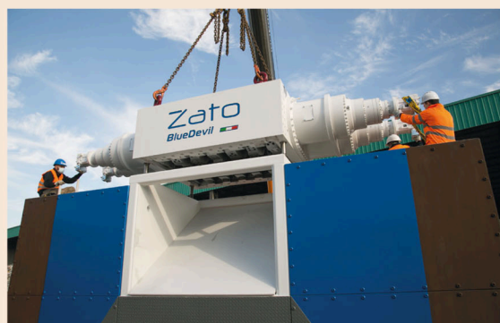
Fase di montaggio di un Trituratore Bialbero per il riciclo di metalli
